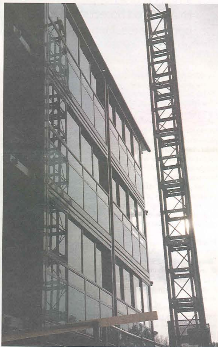
En del støy er det ikke mulig å unngå på et så omfattende byggearbeid. Derfor er det veldig viktig med informasjon både i forkant og under veis, slik at alle er klar over hva som foregår på utsiden av stuevinduet.
